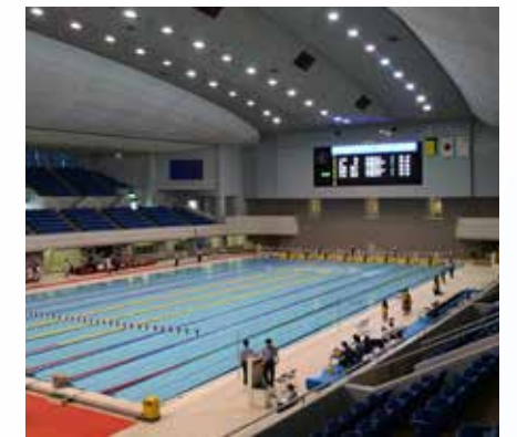
千葉県国際総合水泳場 【大型表示盤】
